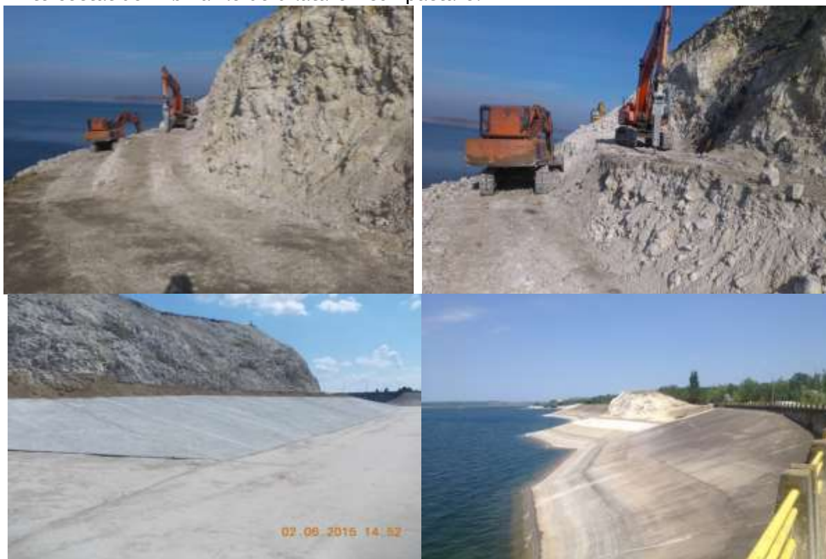
Reducerea pantei și consolidarea malului pe două sectoare ale stâncilor
