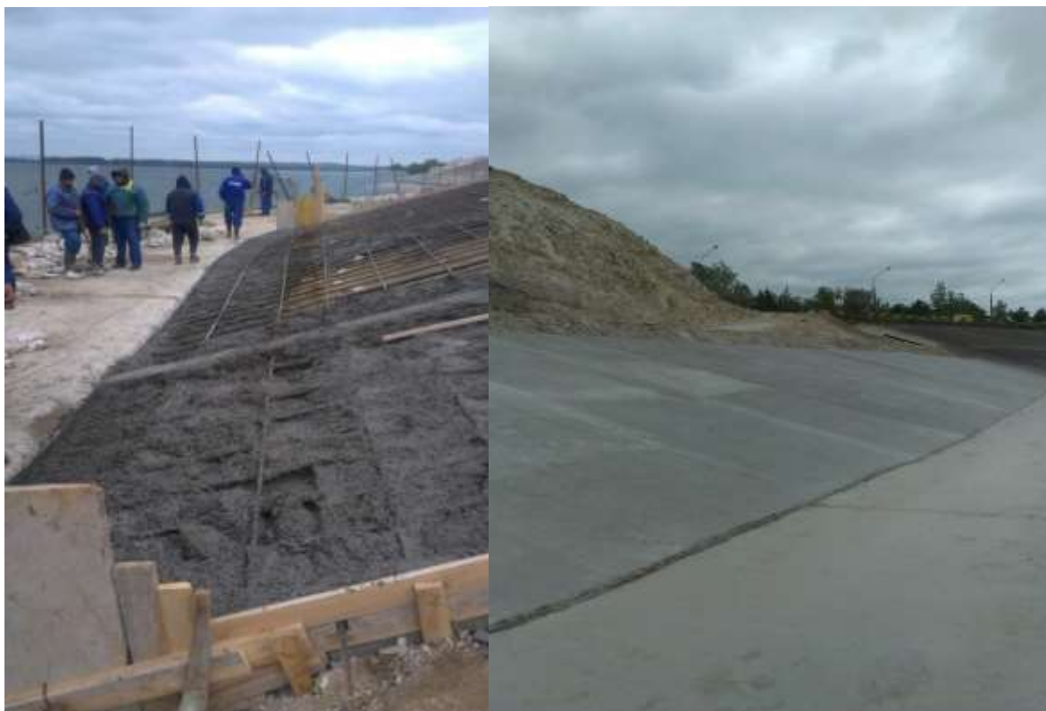
Reinstalarea îmbinărilor între plăci
