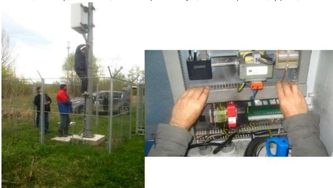
Lucrări de verificare internă și externă (stațiile Oroftiana și Rădăuți)
