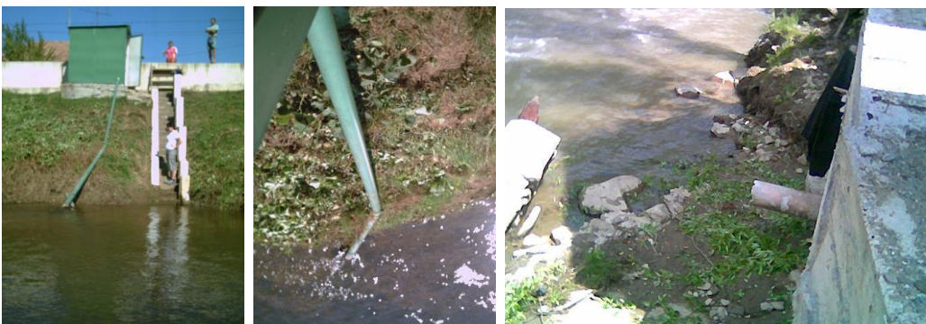
Fig. 4: Infrastructura senzorilor deteriorată de viitură.
